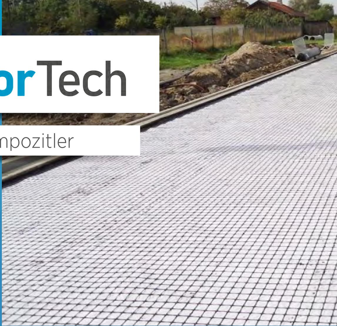
**Fortech GG Geokompozitler**, eşitli altyapı uygulamalarındaki çift veya tek yönlü geogrid ihtiyaçları için geliştirilmiş, ayırma, drenaj ve mukavemet özelliğini tek bir ürünle sunan malzemelerdir.
