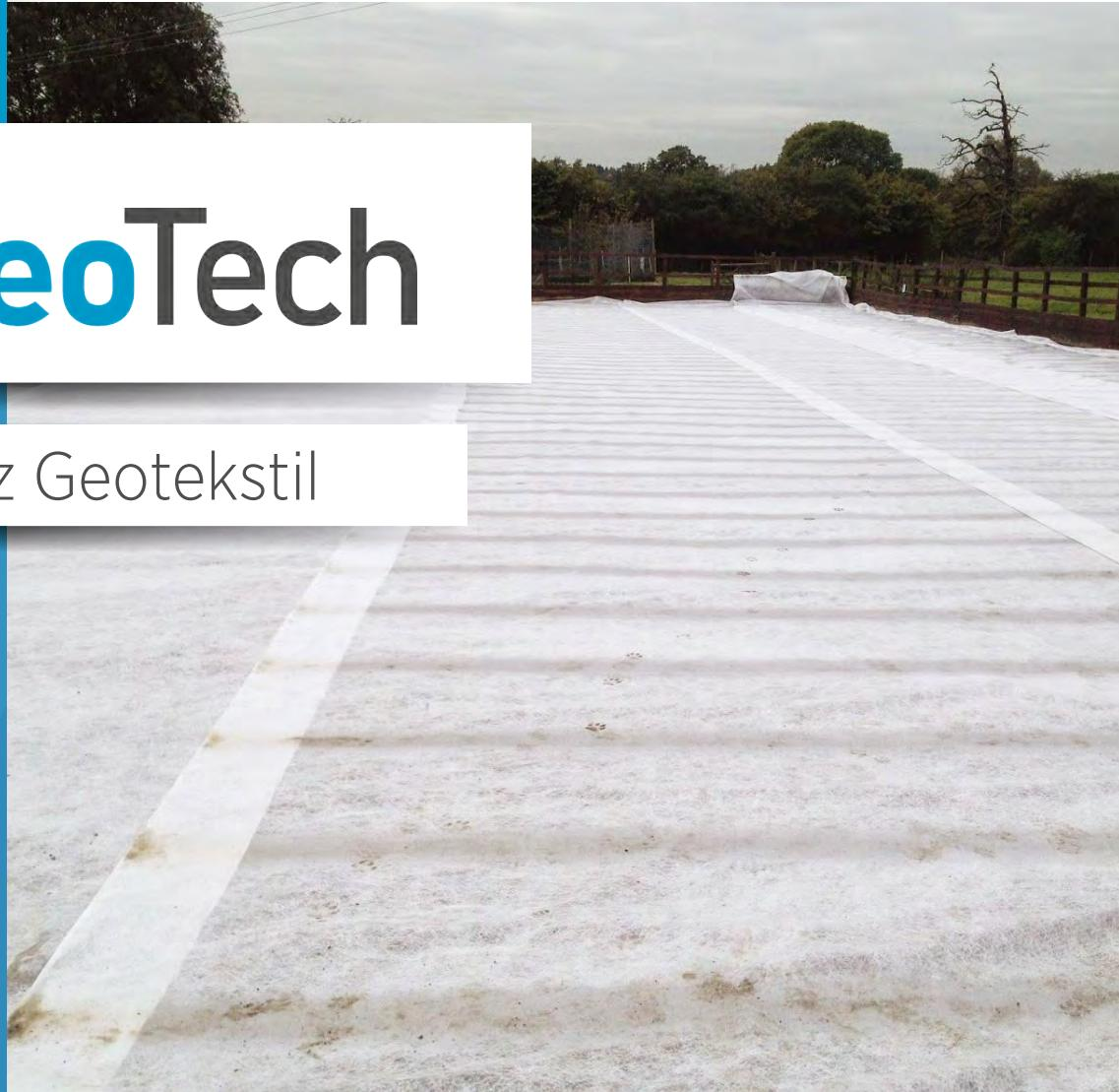
**Jeotech PS Örgüsüz Geotekstiller**, polyester esaslı elyafların iğnelenmesi ve ısıl işlem uygulanması yöntemiyle beyaz renkli olarak üretilen, örgüsüz tekstil ürünüdür.
